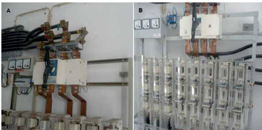
Figura 4.54 – Exemplo de dois interruptores tetrapolares em PTs, A) SOCOMEC Sirco 1250A num PT com potência nominal de 400 kVA B) SOCOMEC Sirco CD 1250A num PT com potência nominal de 2×630 kVA
