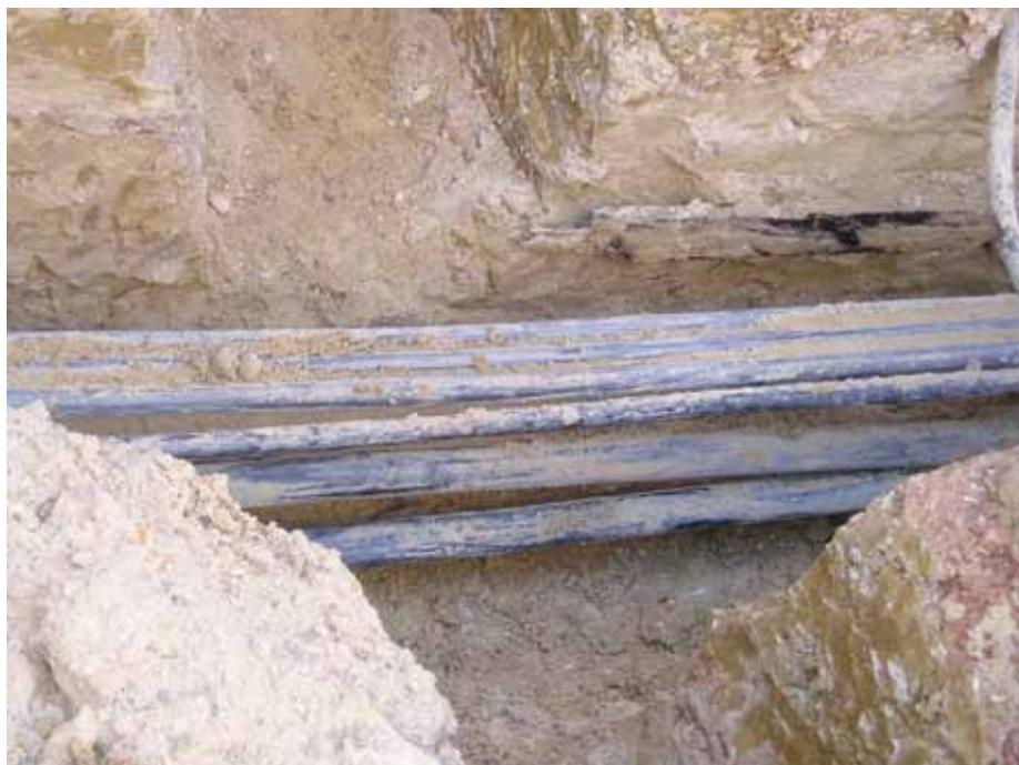
*Figura 3.4 - Fotografia do cabo de 60 kV*
