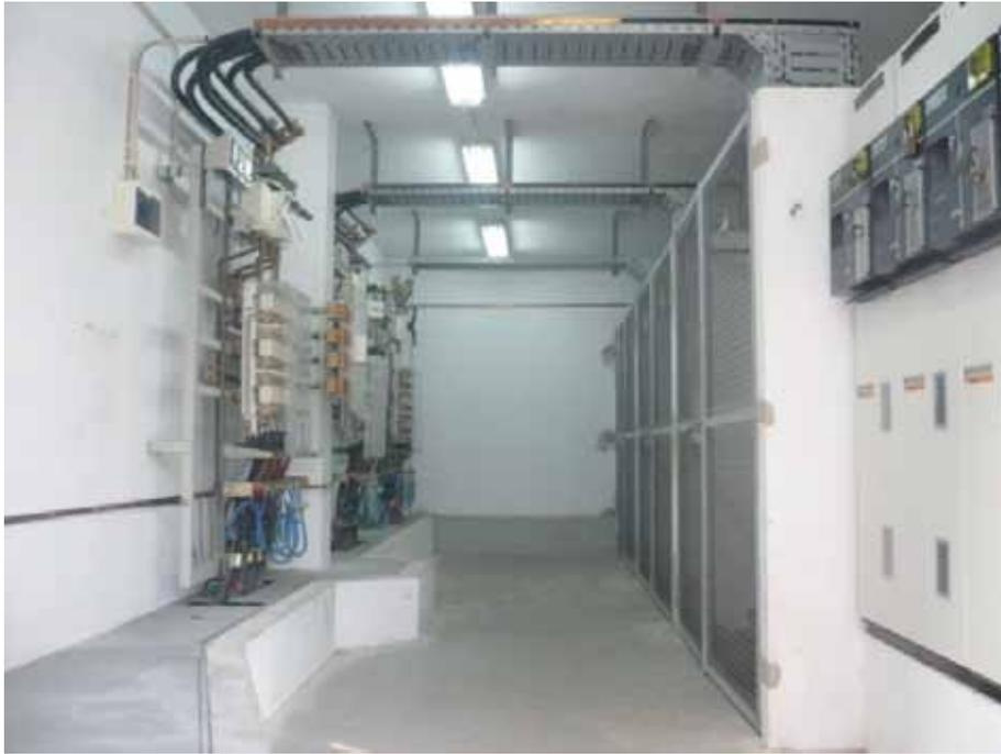
*Figura 4.50 - Exemplo do interior de um Posto de Transformação estudado. Note-se a instalação dos QGBT na parede à esquerda*
