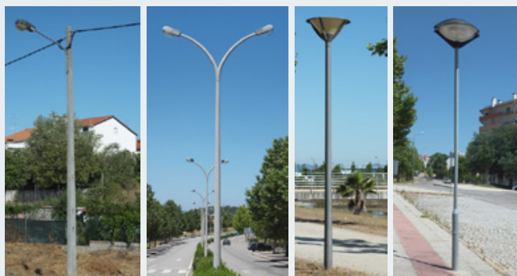
Figura 5.9 – Postes e colunas de iluminação
