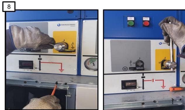
Figura 12 - Desbloqueio de encravamento e abertura do seccionador de terra
