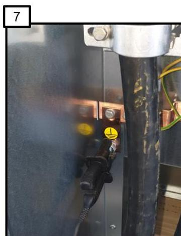
Figura 11 – Ligação do condutor negativo do mega ohmímetro
