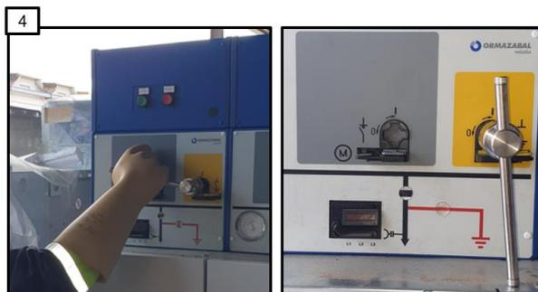
Figura 6 – Fecho do seccionador de terra
