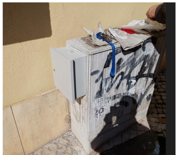
Figura 23 – Caixa P100 fixa ao armário de distribuição, com Gateway PLC instalada no interior e base de fusíveis;
