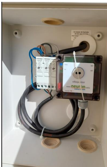
Figura 23 – Caixa P100 fixa ao armário de distribuição, com Gateway PLC instalada no interior e base de fusíveis;
