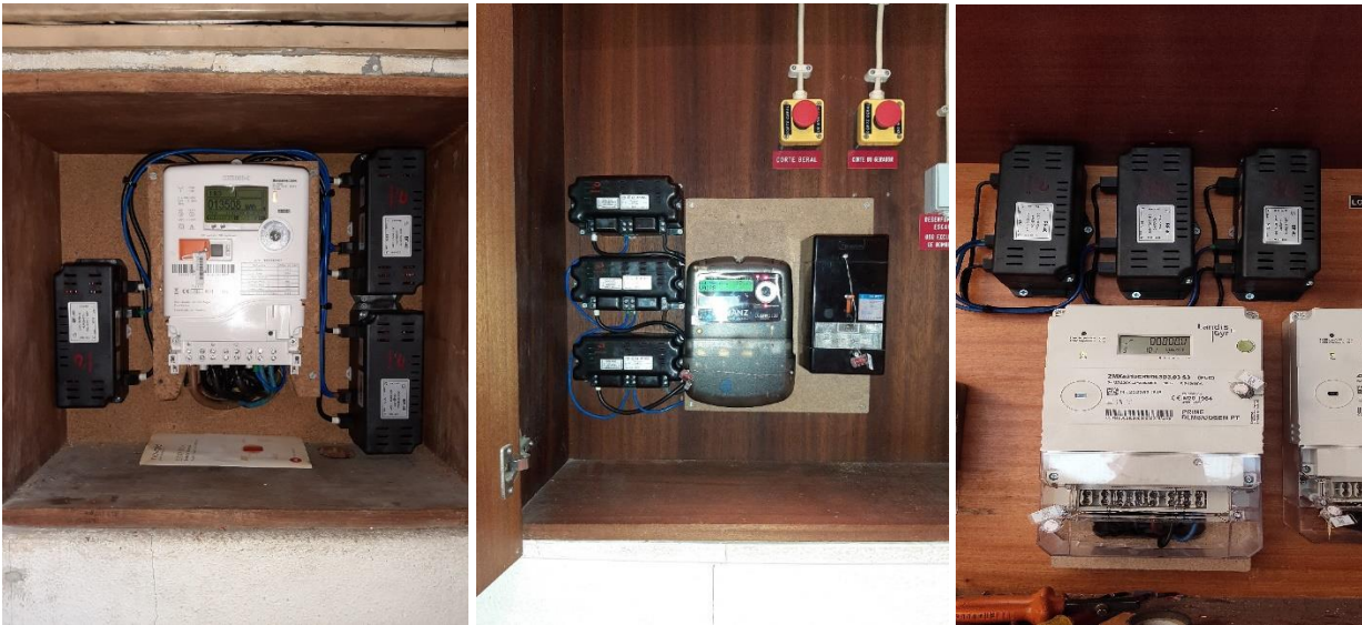
Figura 13 – Exemplo de instalações onde existe espaço para a instalação de Filtro(s) PLC, no mesmo compartimento e no mesmo plano do EMI;
