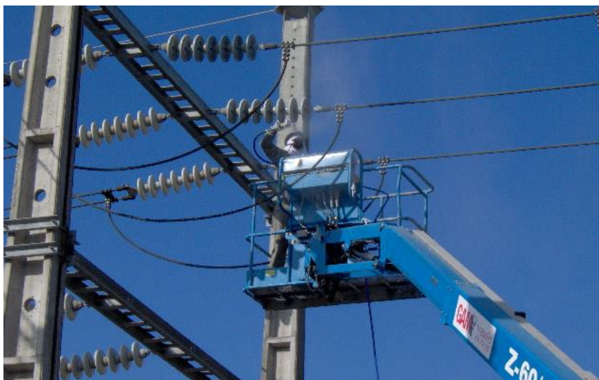
Figura 1 – Exemplo de aplicação da borracha de silicone RTV
